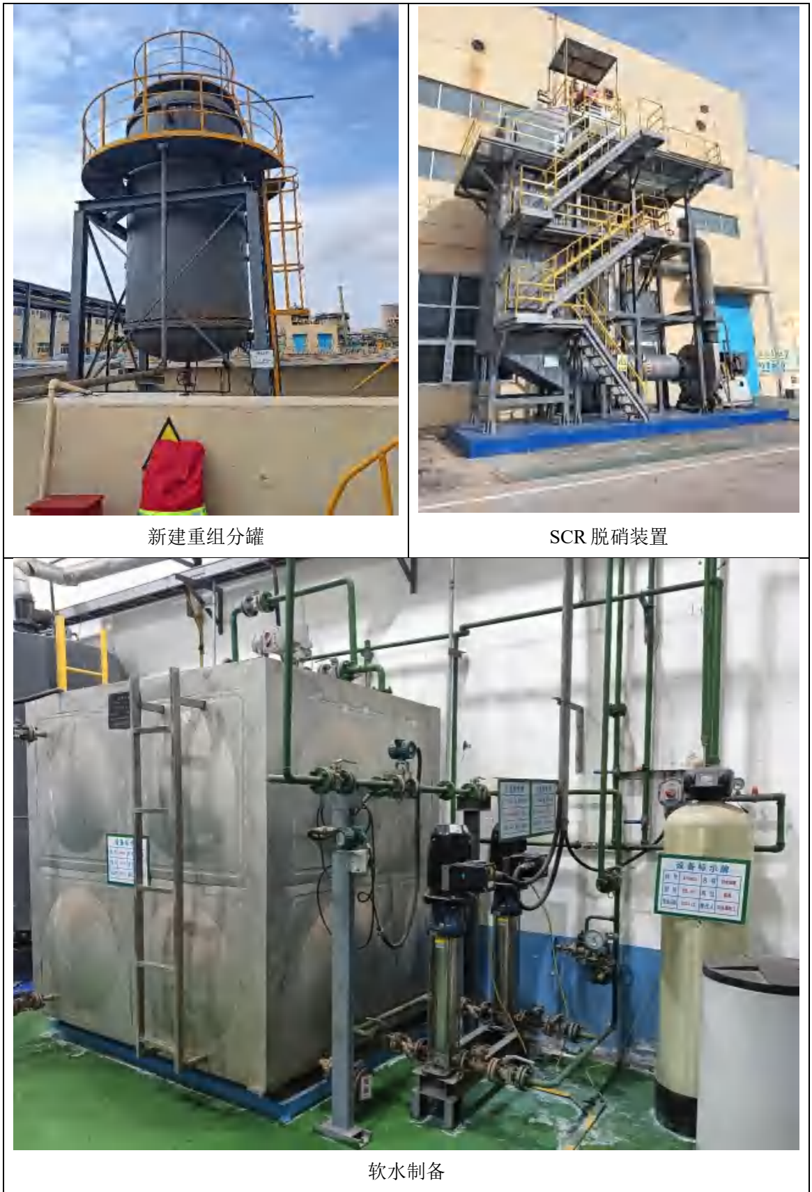
图 4.4-1 本项目建设现状
