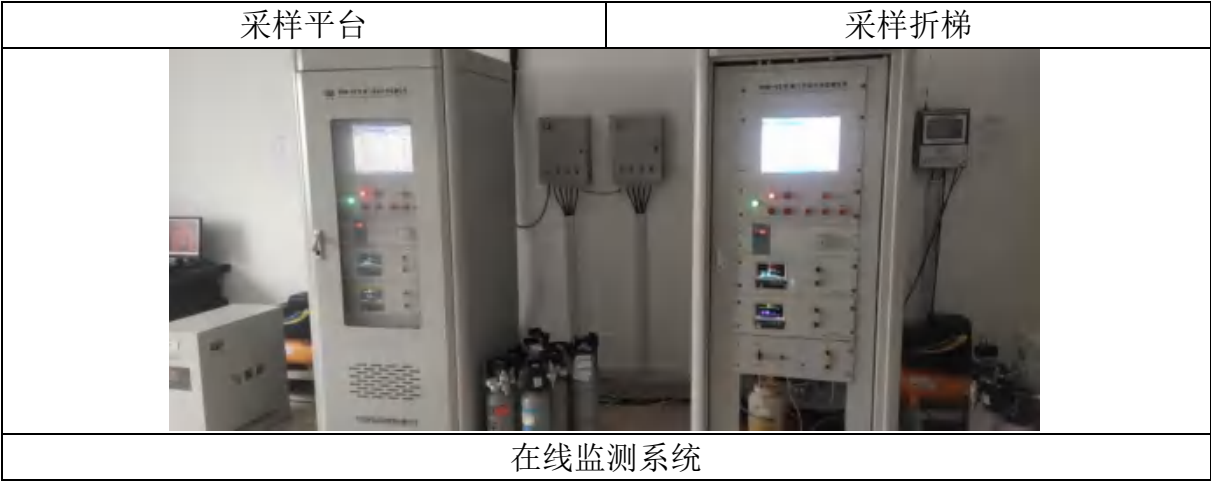
图 5.2-3 废气排放口及在线监测
