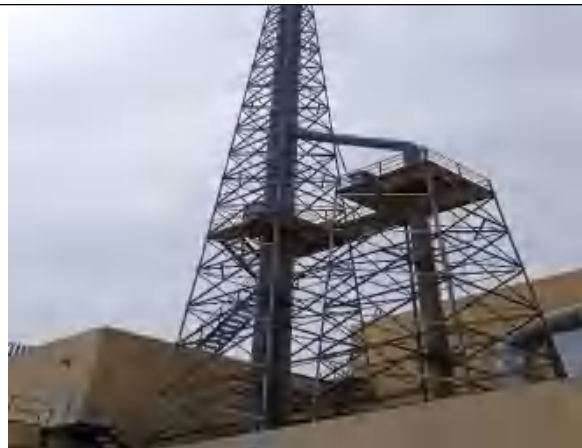
焚烧车间废气排气筒
