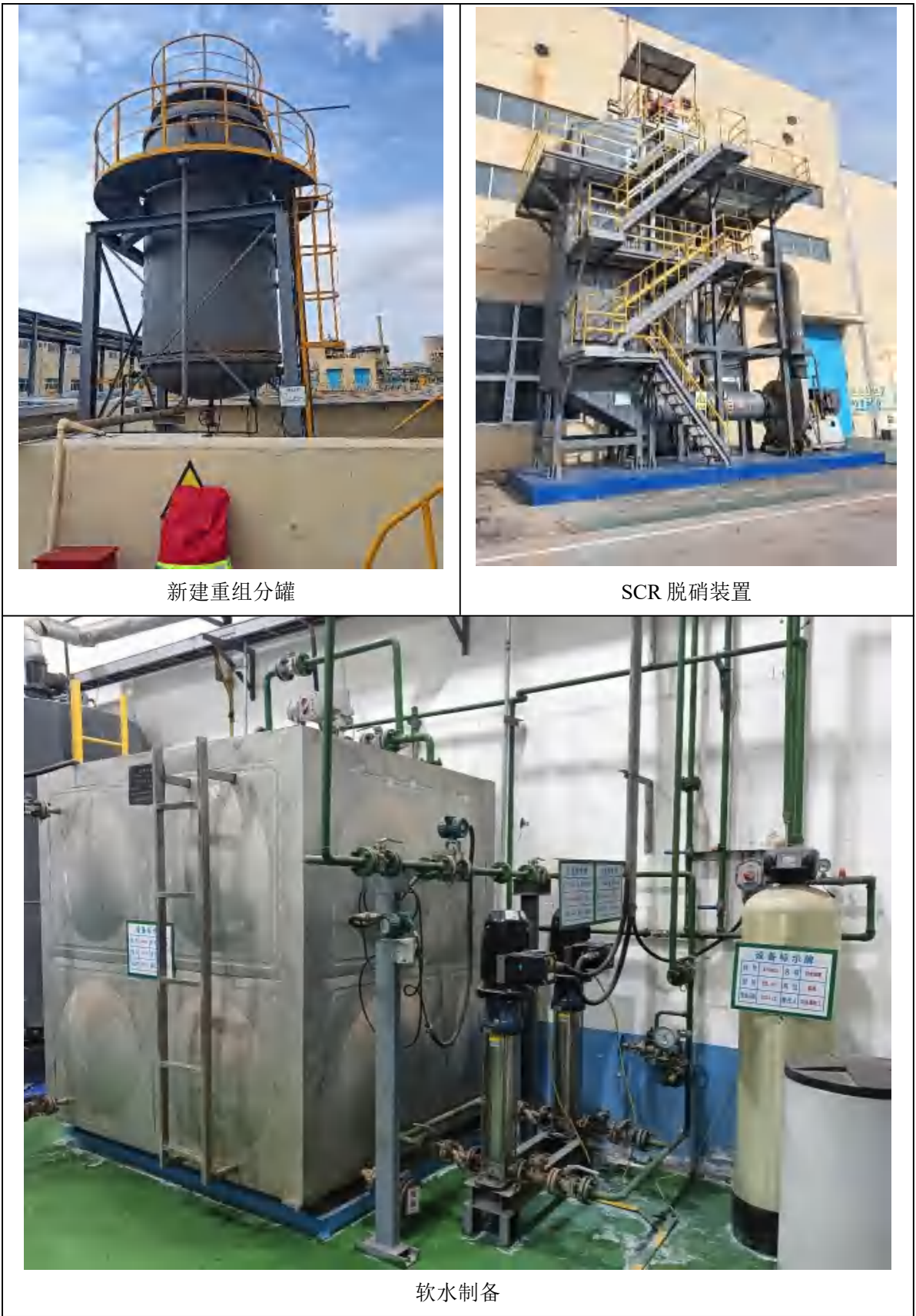
图 4.4-1 本项目建设现状
