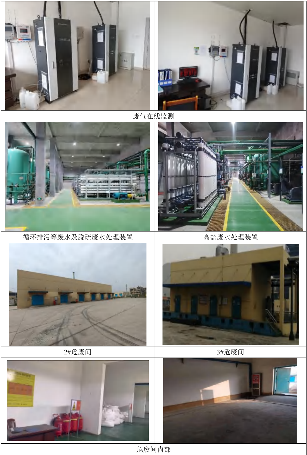
图 3.2-1 现有工程现场图
